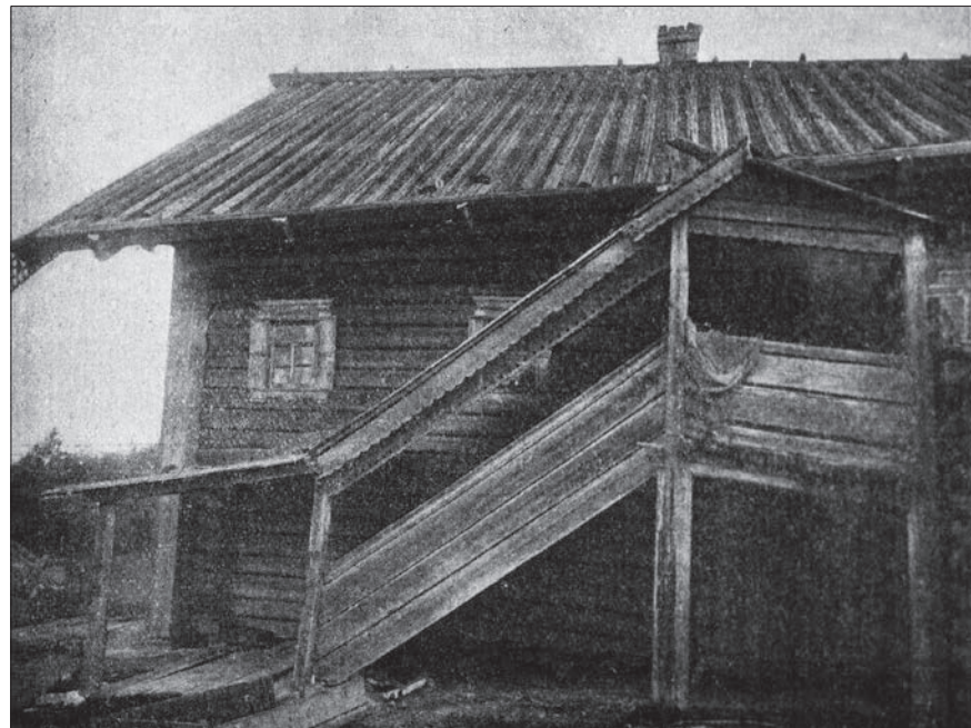
Рис. 9. Крыльцо во втором этаже дома в дер. Няртила Сямозерского района (Карелия)
