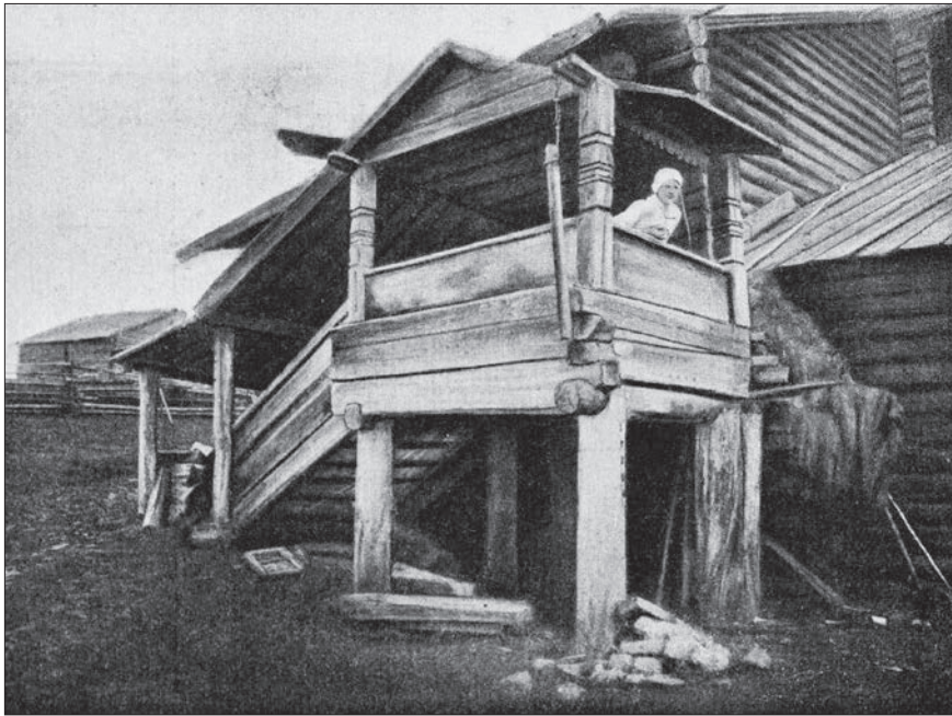
Рис. 10. Крыльцо во втором этаже старого дома в дер. Койкары Петровского района (Карелия)
