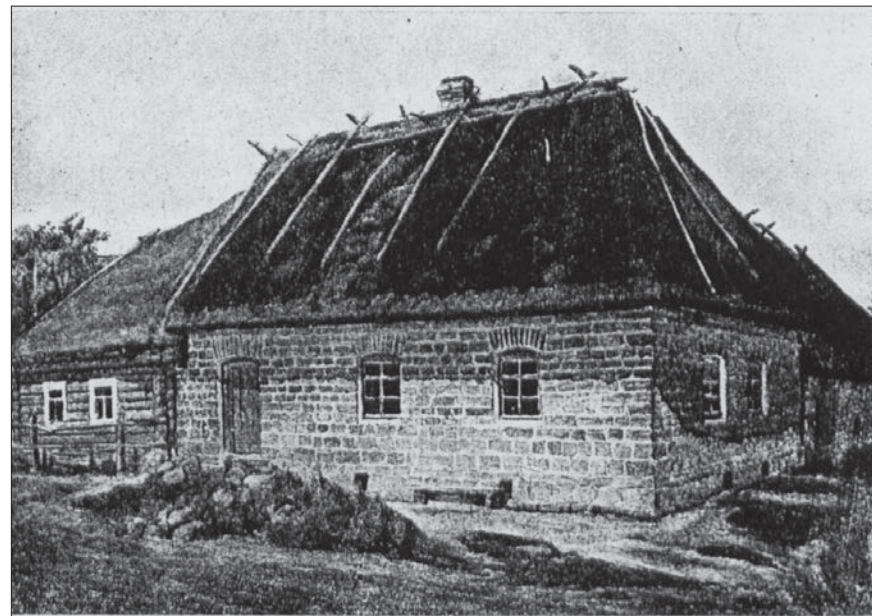
Изба крестьян Алексева и Зайцевой и двор, сложенные из известковой плиты, в дер. Большой Конец б. Котельской волости (акварель).
