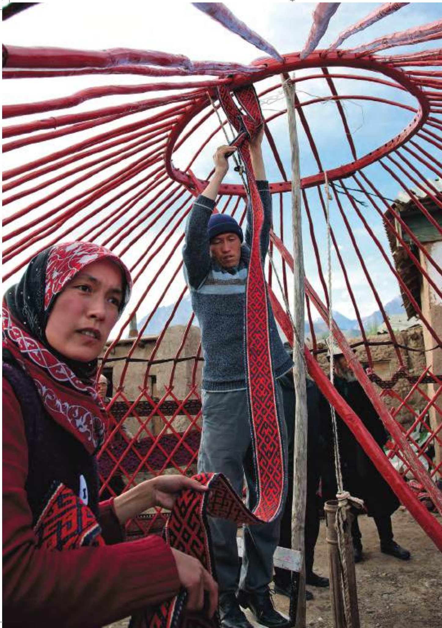
Установка юрты Assembling a yurt
