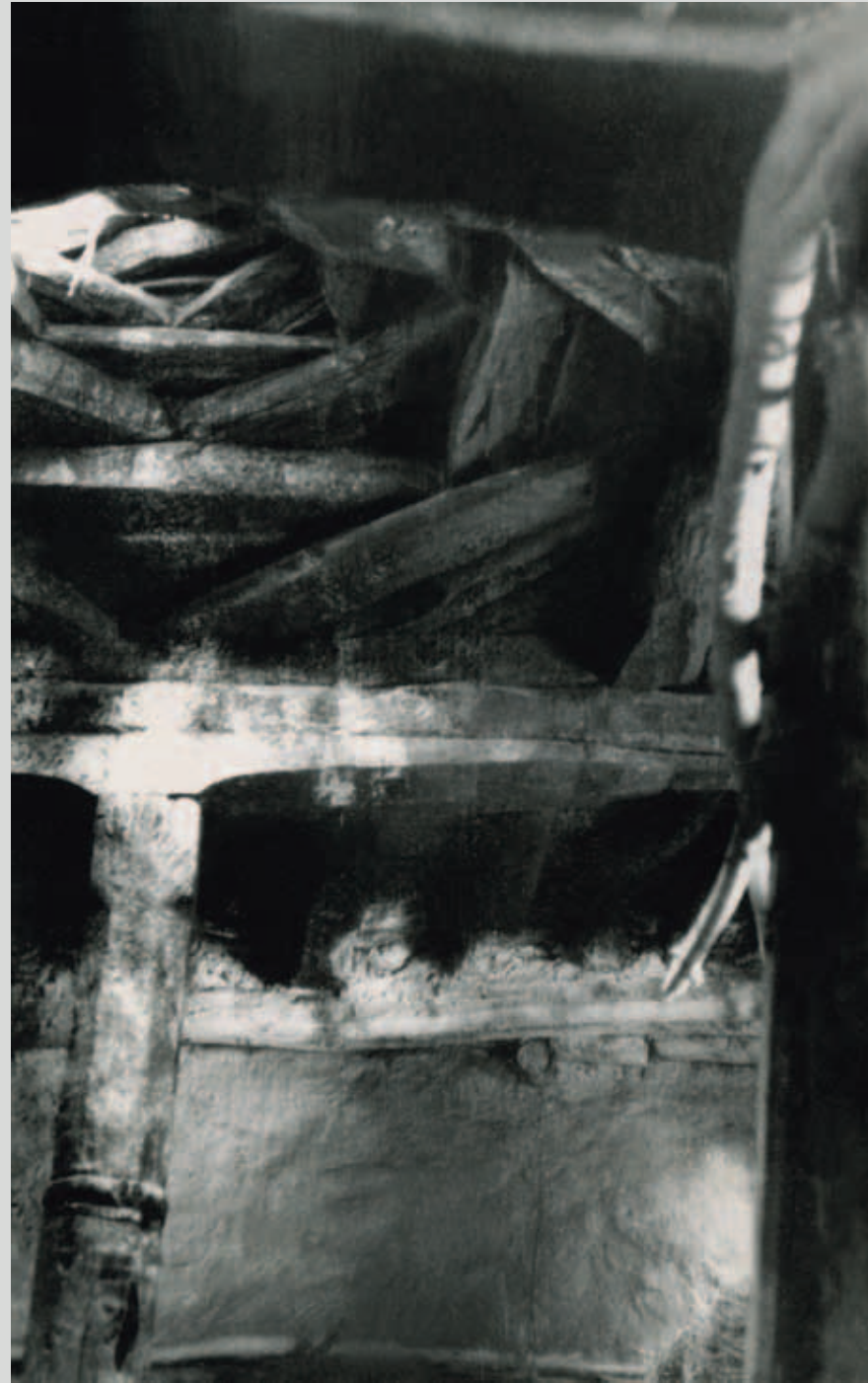
Перекрытие чорхона. Дарваз. 1961 Chorkhona ceiling skylight. Darvaz 1961
