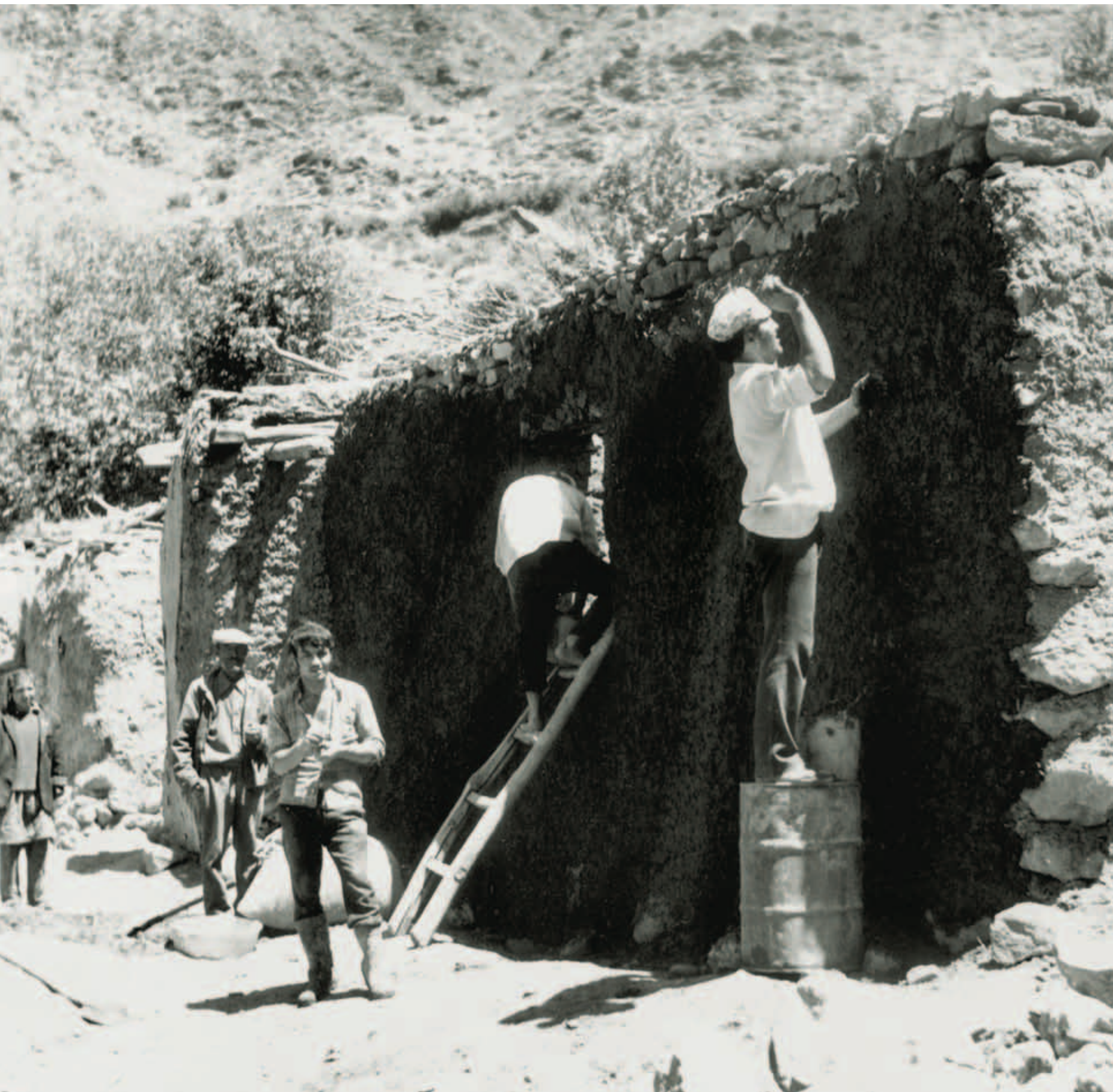
Обмазка глиной каменных стен нового дома. 1977
