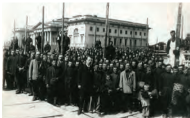
Молебен, посвященный закладке здания Этнографического отдела. Архитектор В. Ф. Свиньин (на переднем плане) со строительными рабочими. 1905 год
