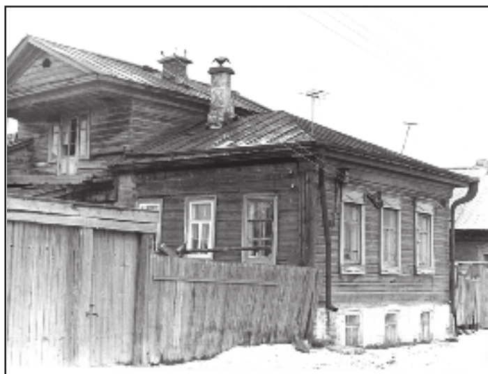
Рис. 4. Дом Ивченко по ул. Мокшинской. Малмыж. Здесь в период с октября 1920 г. по февраль 1925 г. располагался Малмыжский музей местного края. МКМ, № 5706
