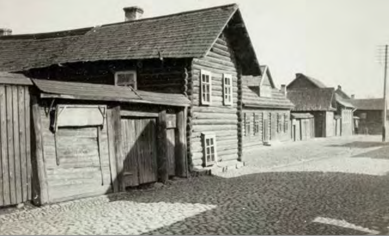
«Дом стрельца» на улице Кеск в городе Печоры (совр. адрес: ул. Э. Верховича, д. 6), первый в ряду уличной застройки. По местному преданию — единственное сохранившееся деревянное здание времен подмонастырской слободы Печеры (XVII в.). Экспедиция Б. Вильде и Л. Зурова. 1937 г. ■ МНБ
